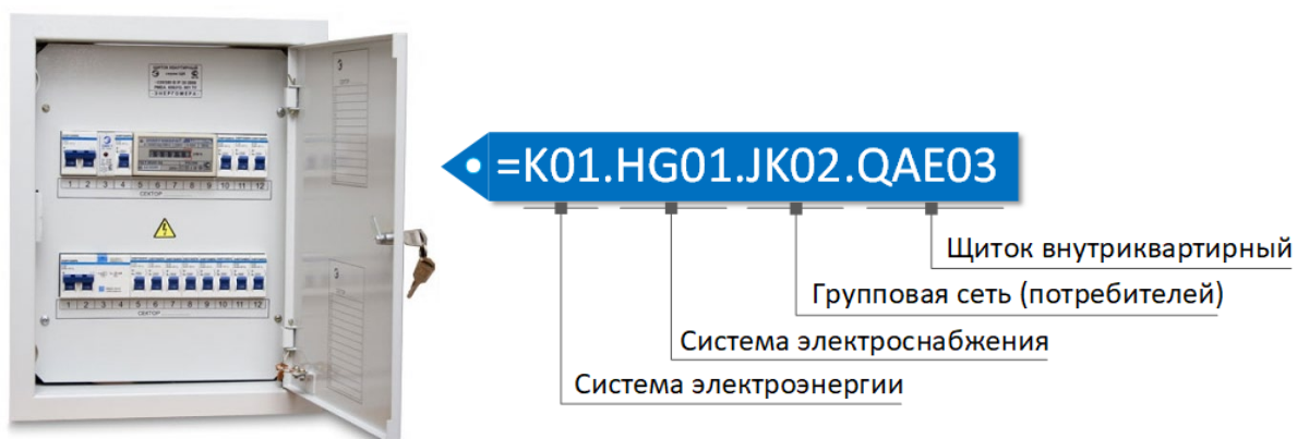
Рисунок Ж.3 – Пример маркировочного кода для внутриквартирного щитка
